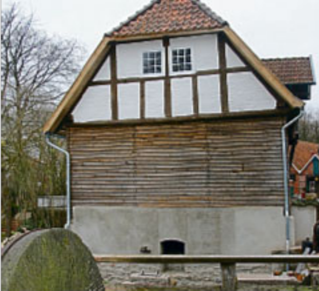
Das Gerüst ist verschwunden: die Fassade der Mühle ist restauriert worden.
