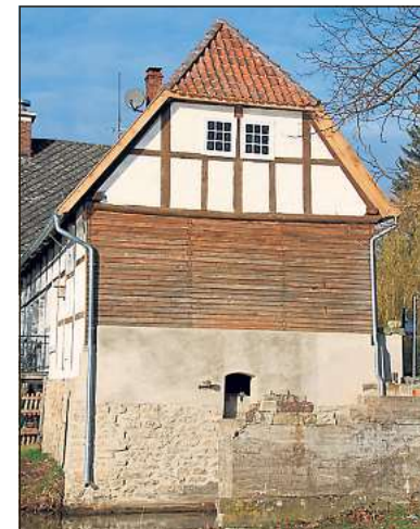
Der Giebel ist restauriert. Jetzt kann das neue Mühlrad kommen.
